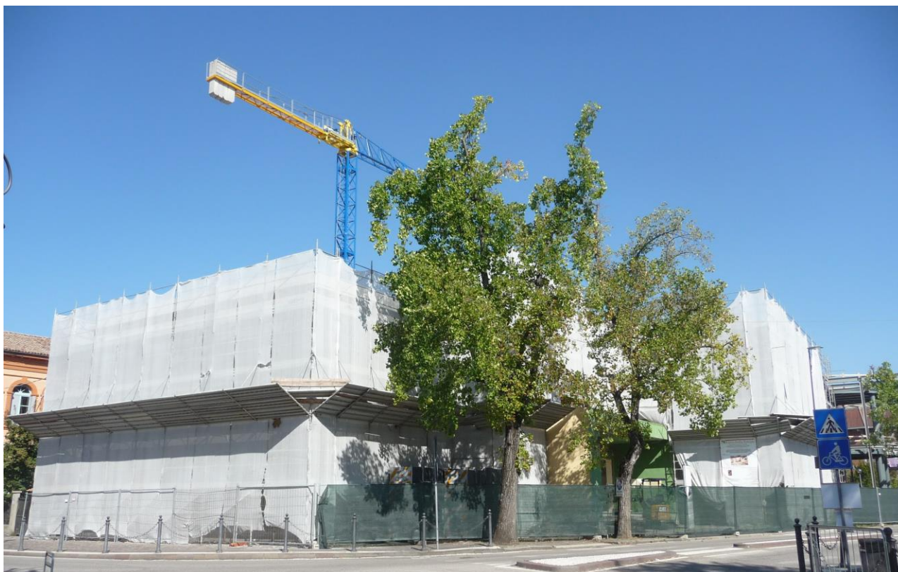
Cantiere dell'Edificio 32 a Reggio
