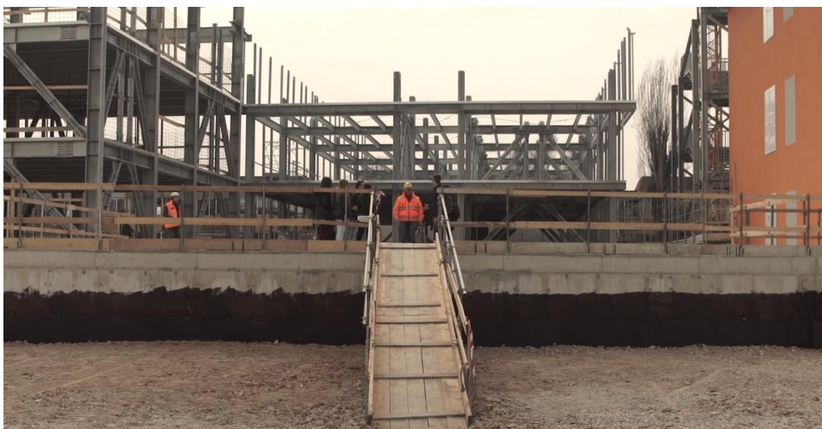
Cantiere dell'Istituto Superiore Statale "Galileo Galilei" – Mirandola
