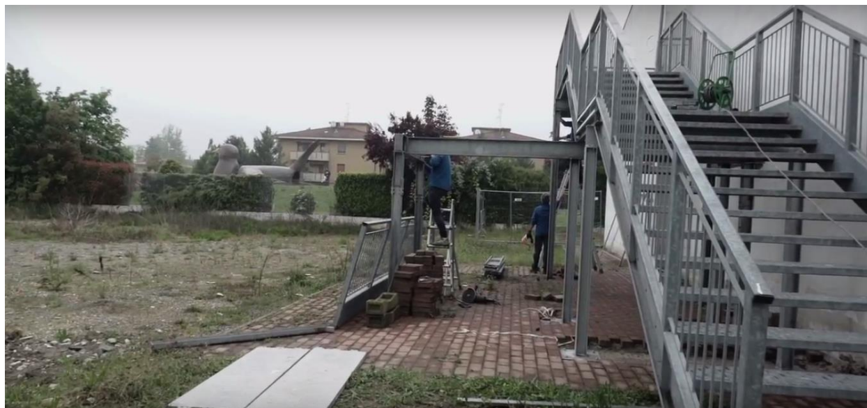
Dettaglio del cantiere della Palestra dell'Istituto ISIT "Bassi Burgatti" – Cento
