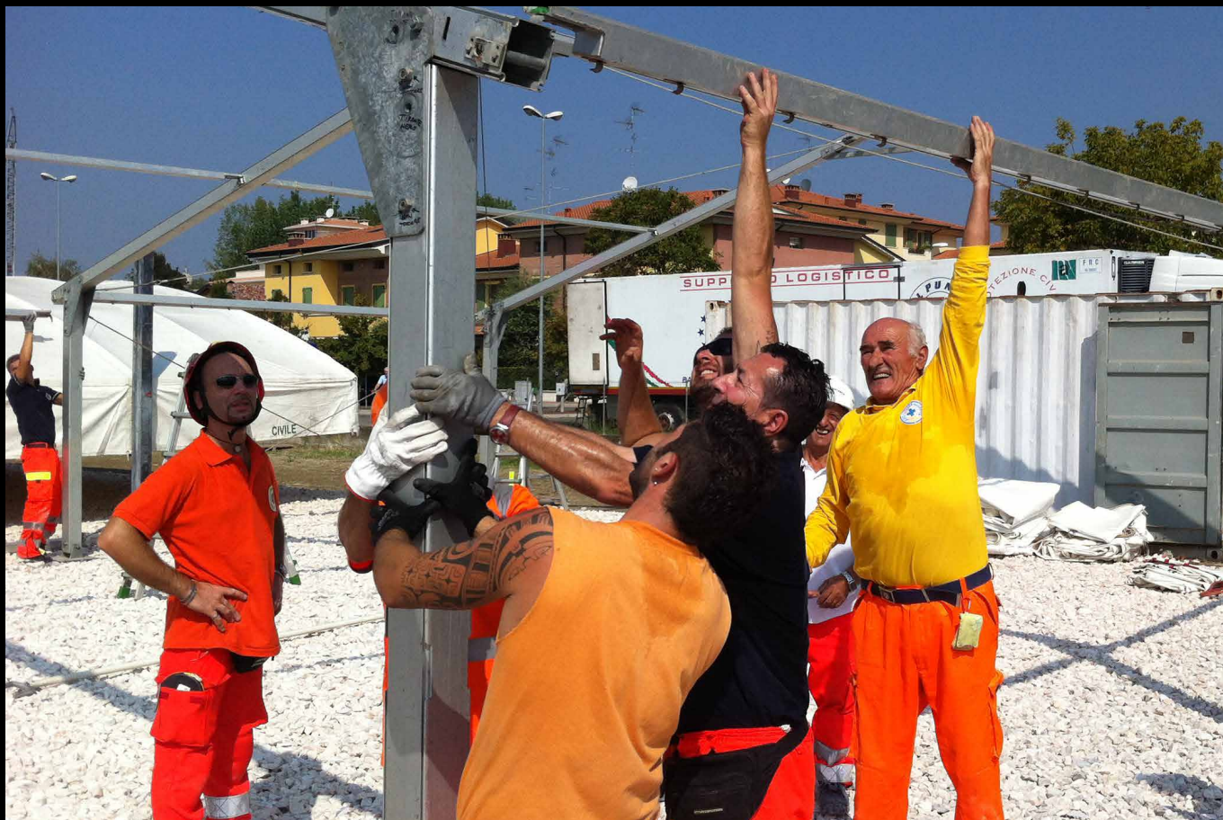
▲ Le tensostrutture per le scuole
