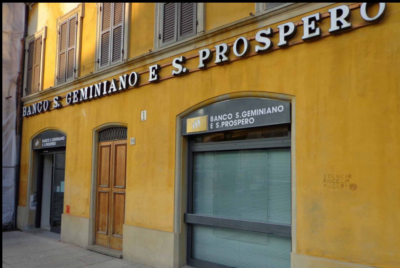
▲ Il Banco rientrato nella sua storica sede dopo il completo restauro
