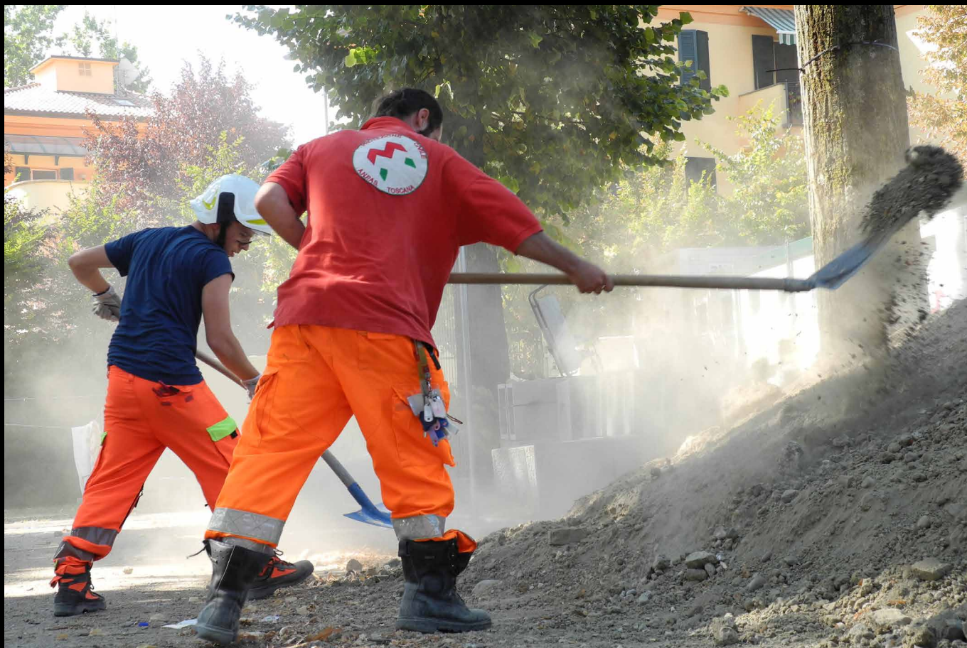
▲ Gli scavi delle fognature del campo Costa
