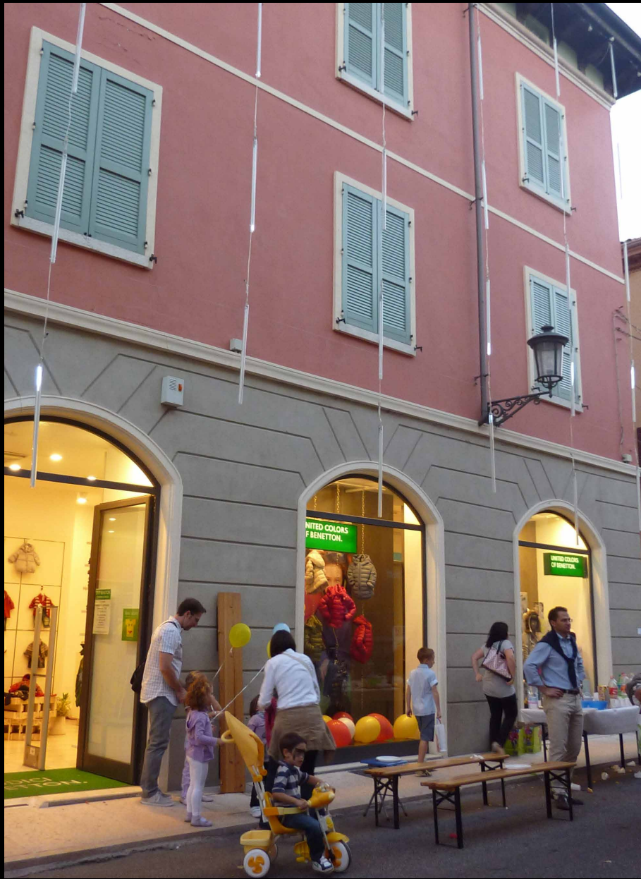
▲ Il centro che rinasce
